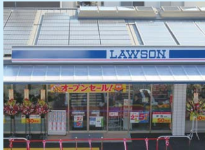
店舗屋根に設置された太陽光発電システム
