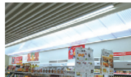
天井に勾配をもたせ、自然換気を促すとともに、トップライトで自然光を採り入れ
