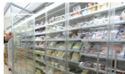
要冷ケースにペアガラスの扉を取り付け、冷気もれを大幅に改善
