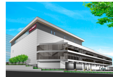
2022年春稼働予定のセントラルキッチン新工場 (神奈川県大和市)の完成イメージ図
