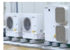
CO 2 冷媒冷凍・冷蔵システム
