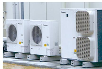
CO2冷媒の冷凍・冷蔵システム
