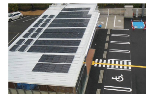
店舗の屋根に設置された太陽光発電システム(パナソニック前店)
