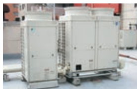
要冷空調一体型システム
