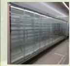
店内の要冷ケースにペアガラスの扉を設置。冷気漏れを防ぐとともに、断熱性能を高めることで、冷蔵効率をアップ。
