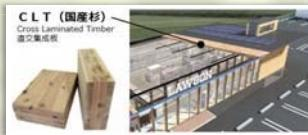
店舗の屋根・天井部に、断熱性の高いCLT(直交集成板)を使用し、建物の断熱性能を向上。空調機器の負担を軽減することで省エネを実現するとともに国産の木材を使用することで、店舗建設時のCO<sub>2</sub>排出量を削減。
