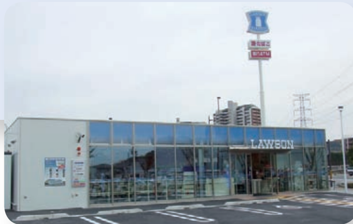
節電時代に対応した創エネ店舗
