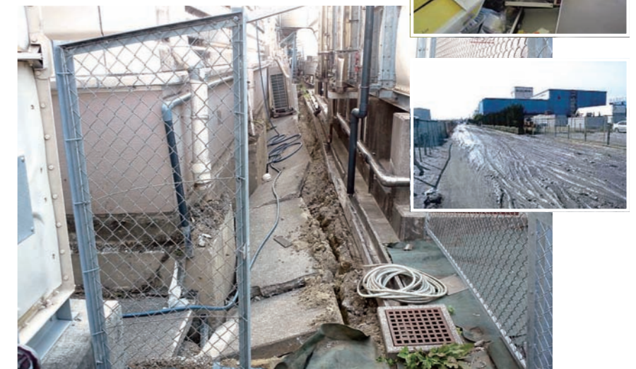
船橋市のB工場は液状化の影響で大きな損傷を受けた
