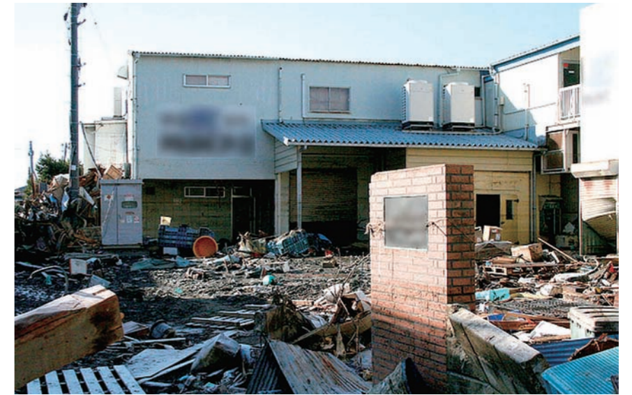
水産工場の倉庫は津波の被害を大きく受け、いくらわかめなどの原料調達が困難になった
