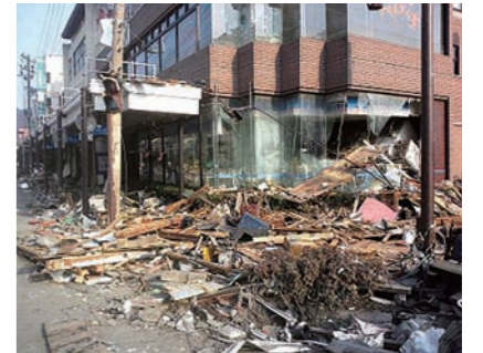
地震による破損、津波による流出など大きな被害が出た
