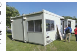
熊本地震で設置したプレハブ仕様のコミュニティスペース
