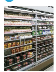
ショーケースに扉を つけて冷気漏れを防 ぐとともに、断熱材 を強化して断熱性能 を高めることで、冷 蔵効率をアップ。
