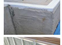
料で基礎と外壁を断 熱することで、建物 の断熱性能を向上さ せ、基礎と外壁から 店内への熱負荷を 軽減。
