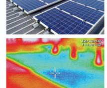
屋根に太陽光パネル を設置して直達日射 を遮ることで、屋根 面の温度上昇を抑制 し、屋根から店内へ の熱負荷を軽減。
