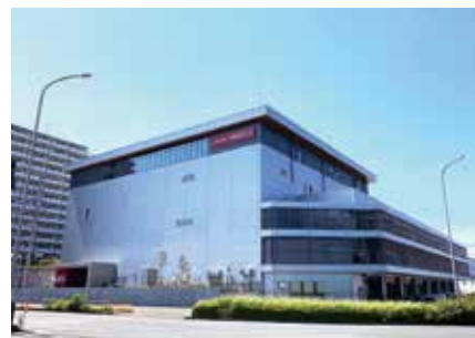
大和第三セントラルキッチン
